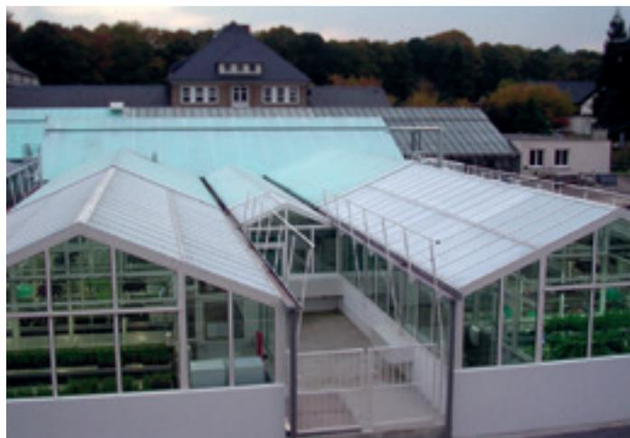
Les serres de sécurité biologique en 2005, attenantes au groupe de salles climatisées, l'ensemble formant un dispositif de sécurité de niveau 3.
