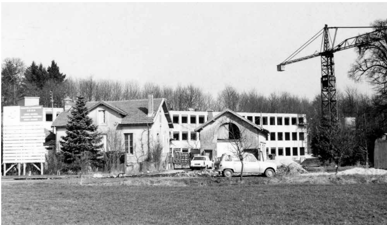
Construction du centre national de recherches forestières à Champenoux, 1970. Au premier plan à gauche, l'ancienne maison forestière.
