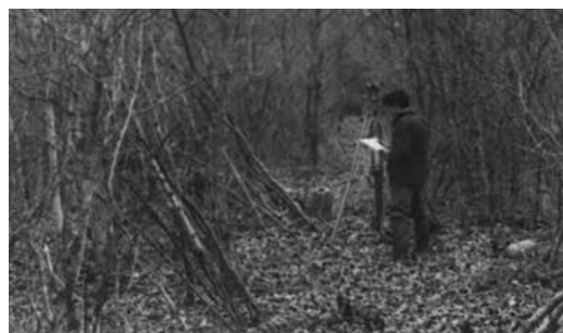
Défrichage de ce qui deviendra le centre d'Orléans, début des années 1970.
